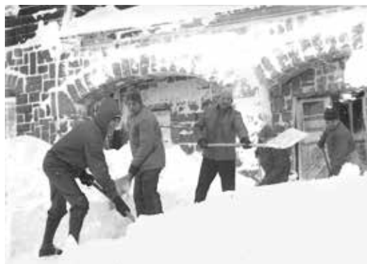
PREVENTIVNÍ REHABILITACE OVČÁRNA, ODKLÍZENÍ SNĚHU
