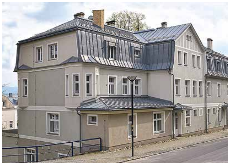
BUDOVA GRÜNBAUM DNES
